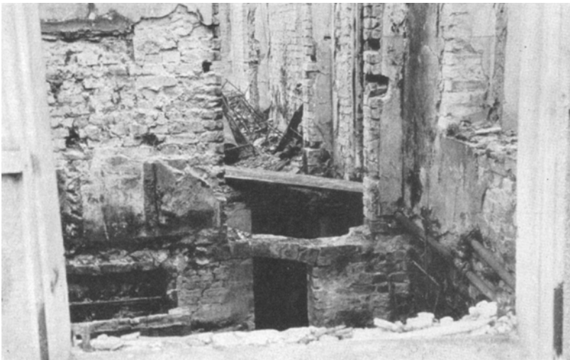
Abb. 15. Tatortaufnahme zum Mordfall Schmiede. Vorn die eingestürzten Kellerdecken, im Hintergrund die unversehrte Betondecke des Heizkellers.
